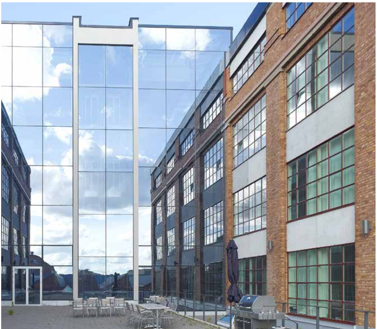
Facadesystem 4150 SSG på AGA-verken på Lidingö, Stockholm
